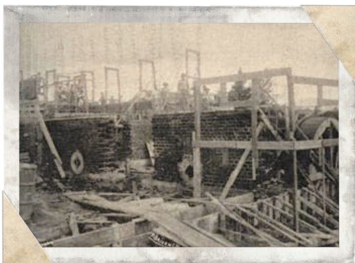
Escuela República Argentina en construcción, 1934. Construcción del sótano.
