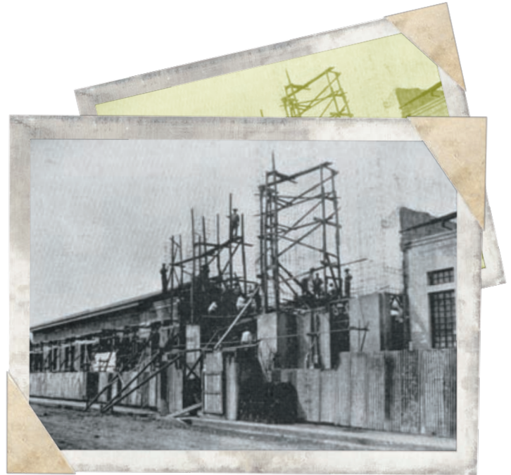
Fachada de la edificación en construcción.
