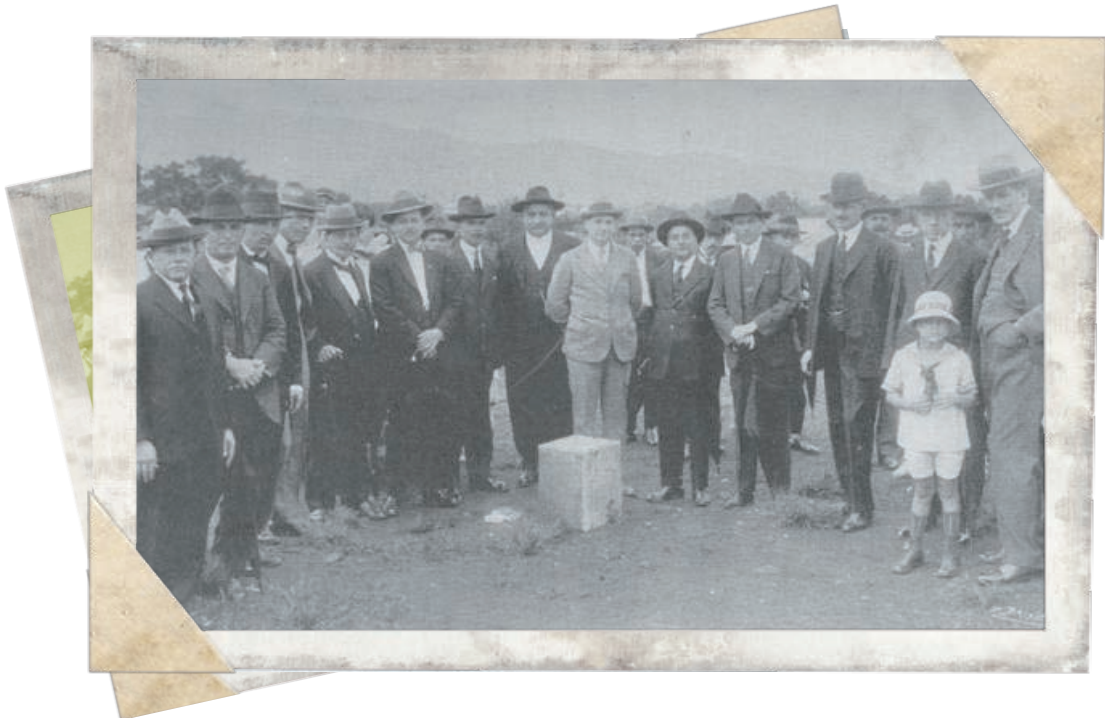
Acto conmemorativo de inicio de las obras de construcción del primer edificio escolar de Barrio México, 1926. Fuente: Memoria de la Secretaría de Educación, 1926.
