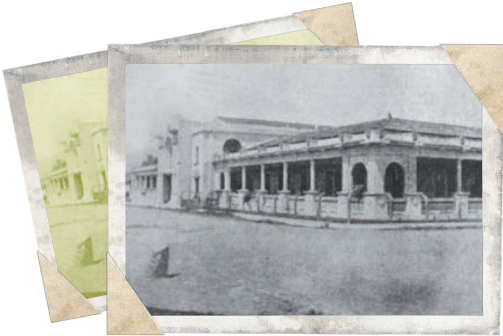
Edificio de la Escuela República Argentina recién construido, 1935.
