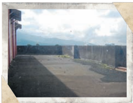
Losa de concreto
