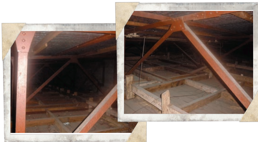
Fotografías recientes de la estructura de techos
