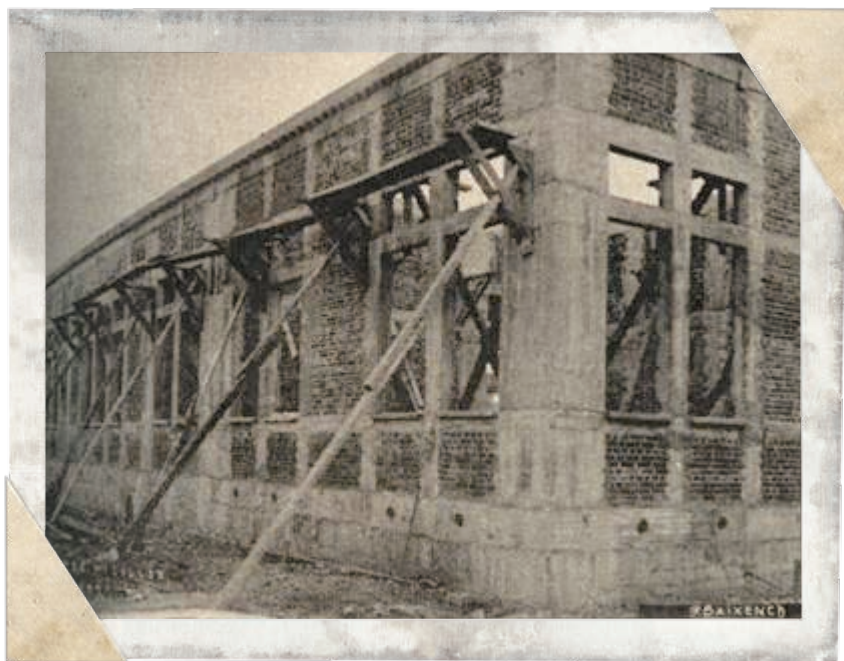
Escuela República Argentina en construcción, 1934.
